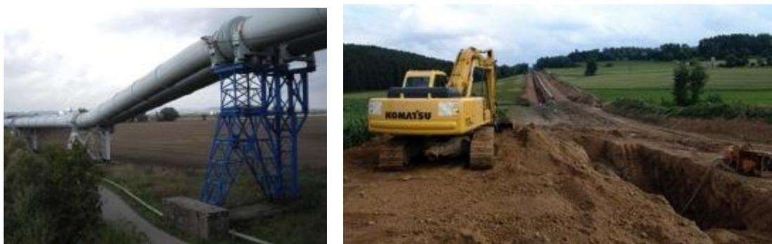
Foto de la izquierda: tubería por encima del suelo, Guénange, Moselle, Francia © 2010 Benjamin Smith, Creative Commons. Foto de la derecha: soterramiento de una tubería a lo largo de la servidumbre de paso © 2007 Creative Commons.
