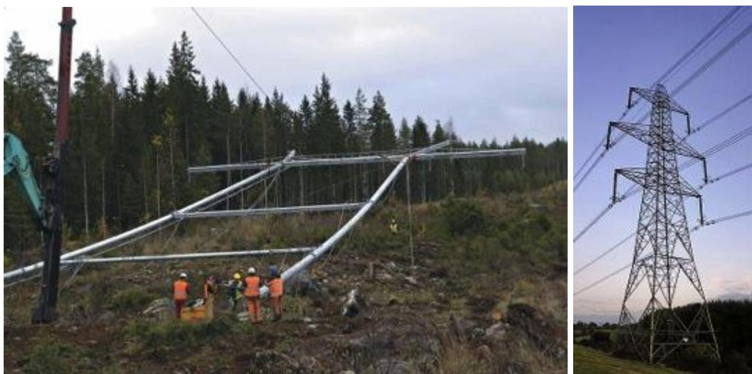
Foto de la izquierda: construcción de un tendido eléctrico aéreo en Hill of Aldi, Reino Unido © Anne Burgess, Creative Commons, Foto de la derecha: línea de transporte monotensión de doble circuito; «en haz» de cuatro © yummifruitbat, Creative Commons.
